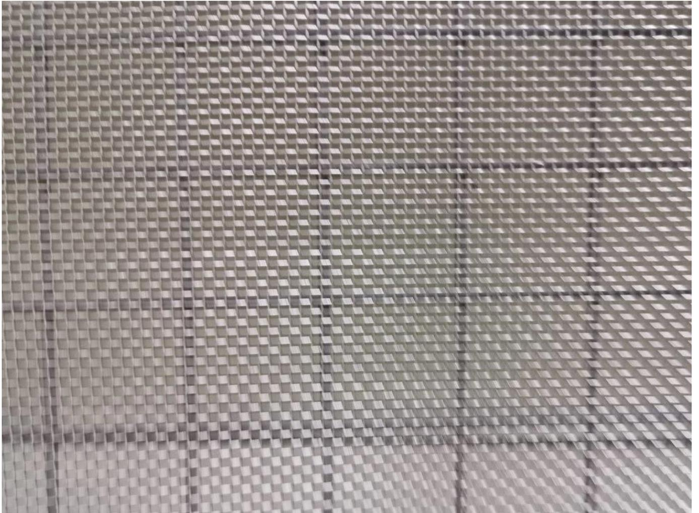
Pelat mesh stainless steel halus diadopsi untuk memastikan volume udara dan menyaring daun patah yang sangat kecil.
